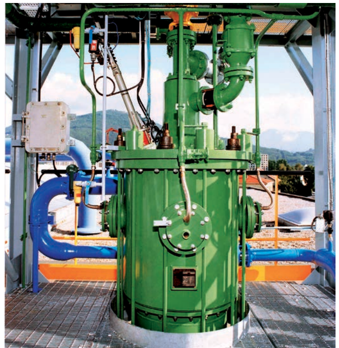
↑ 燃烧室顶部及点火系统
